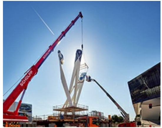
Demontage der drei Porsche 911 in Zuffenhausen
